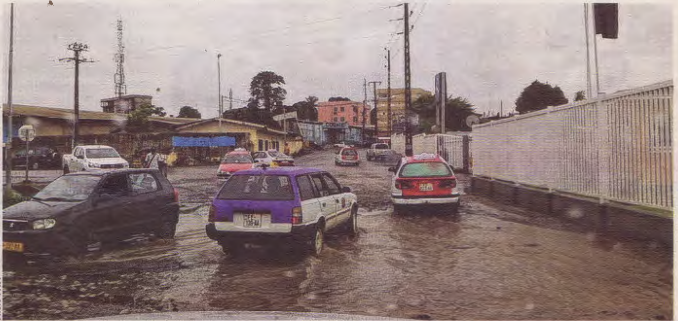
A Oloumi, en face de Tractafic, l'état de dégradation de la chaussée aggravé par les eaux stagnantes.
