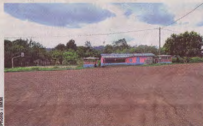
L'un des quartiers de la ville dépourvu de l'éclairage public.
