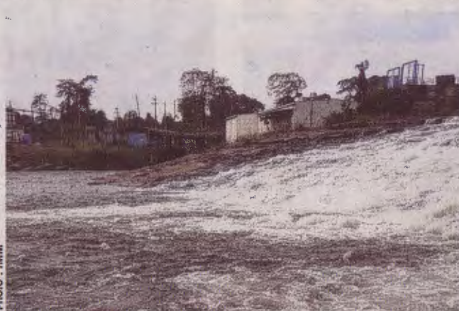
Le barrage hydroélectrique construit sur la rivière Louétsi. Des retombées toujours attendues par les populations riveraines.
