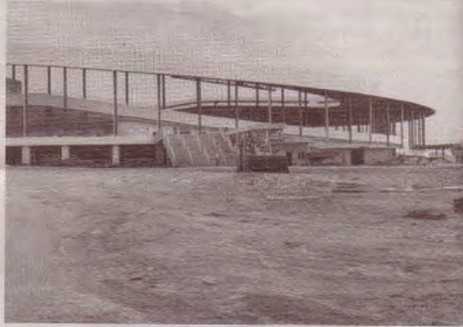
Les travaux de terrassement ne font que débuter. (Photo du 19 novembre)
