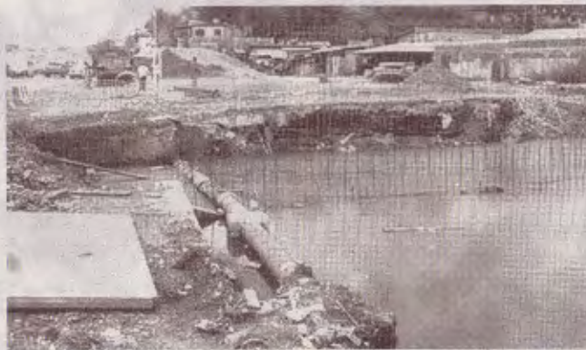
Les travaux de la route avancent à pas de tortue
