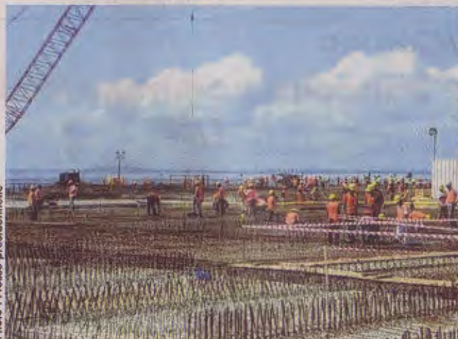
Une vue du chantier du futur port de commerce d'Owendo.
