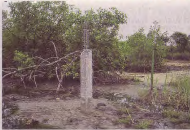
Construction dans la mangrove à Nzeng-Ayong.
