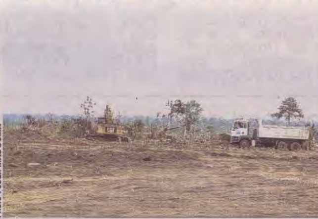
Le terrassement d'une zone de mangrove à Bikélé
