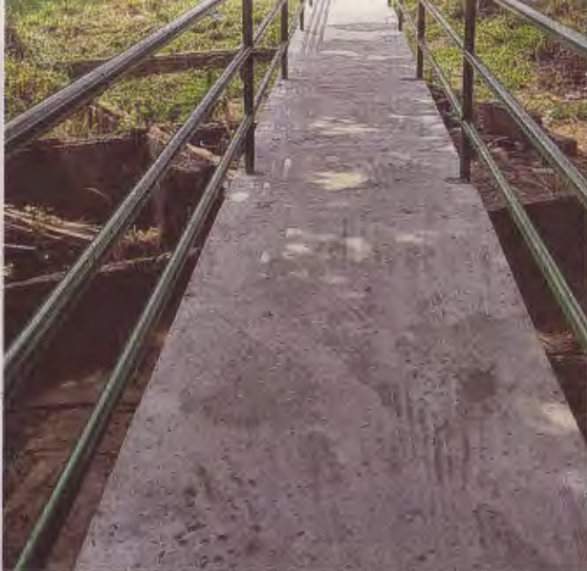
Une vue partielle de la passerelle longue de 65 mètres.
