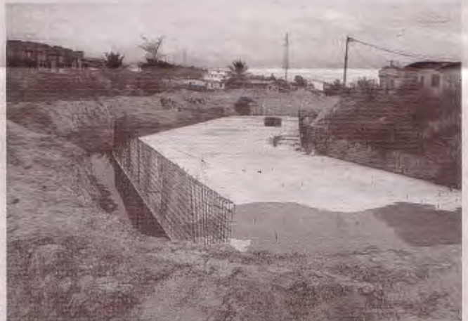
Vers le pont de la Nouvelle cité sans repère, l'on peut penser que le chantier est arrêté.
