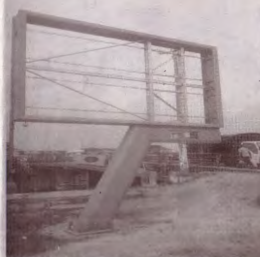
Exemple de l'installation d'un nouveau panneau.
