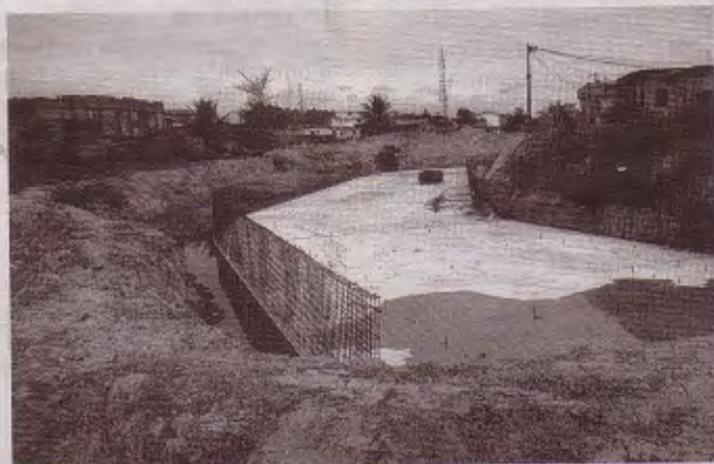
Les travaux entrepris sont à l'arrêt depuis quelques jours, l'Etat n'ayant pas honoré à ses engagements.
