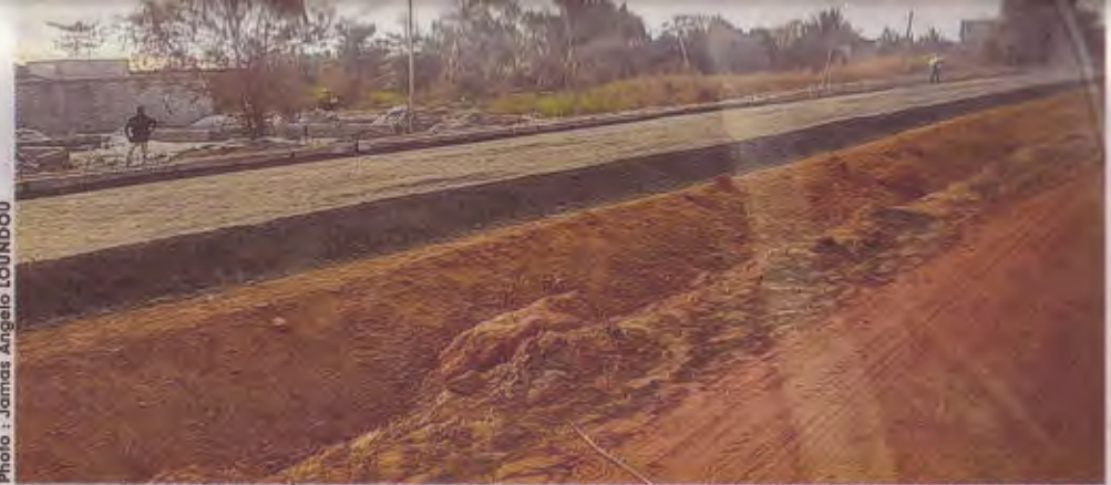
La route de 4 kilomètres qui va relier le centre-ville de Port-Gentil au stade est en construction.
