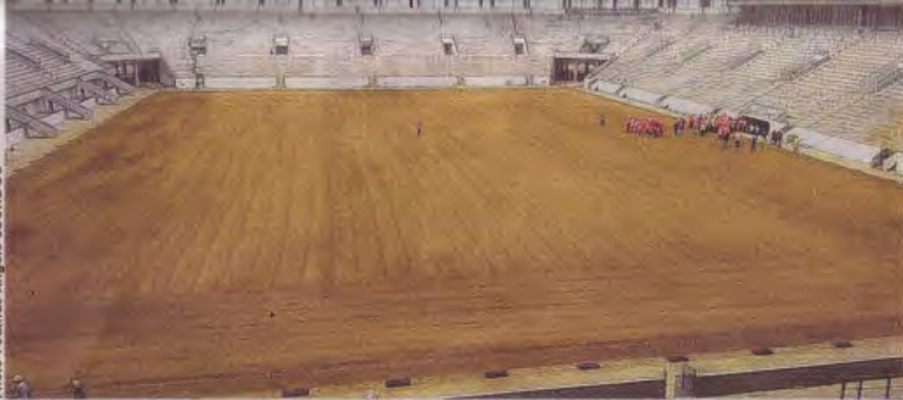
L'aire de jeu du futur stade, toujours en travaux.
