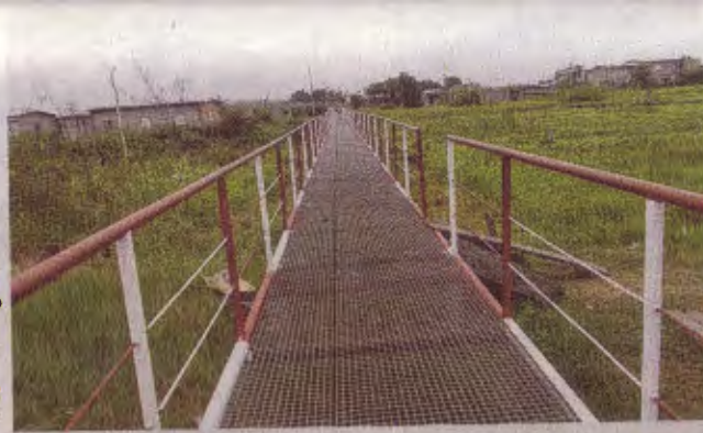
La nouvelle passerelle, de la belle ouvrage!
