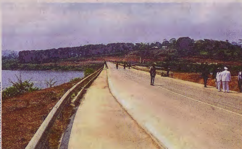
La route Mayumba-Tchibanga désormais bitumée.
