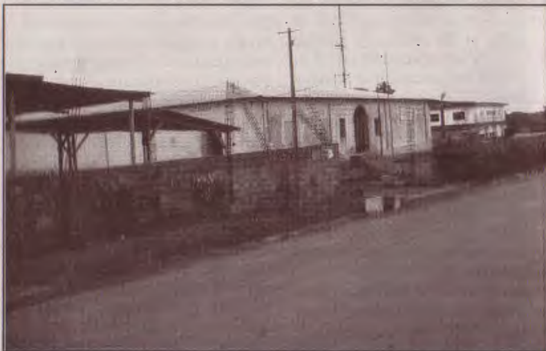
La prison centrale de Makokou, un bâtiment vétuste ne présentant aucune garantie de sécurité. On peut apercevoir le hangar qui sert de bureau aux gardes pénitentiaires.
