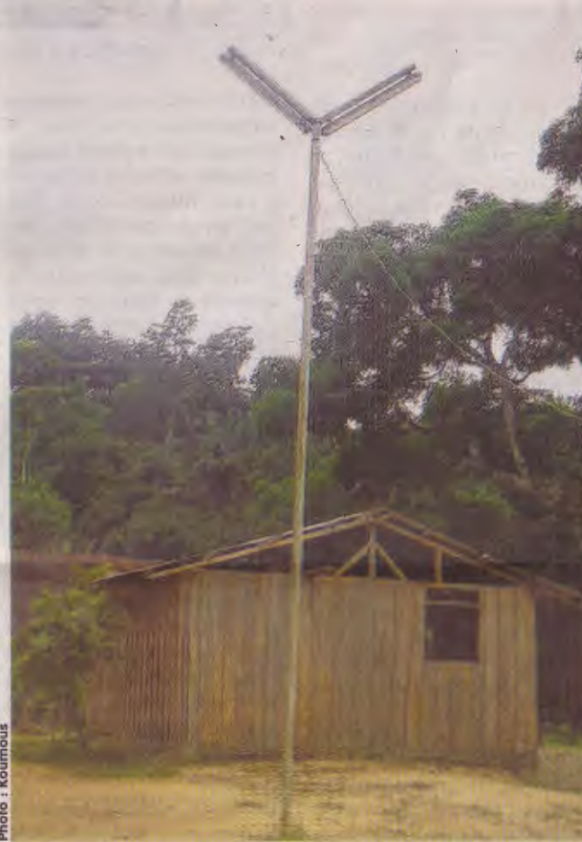
Des poteaux électriques au village Okoumikassa.
